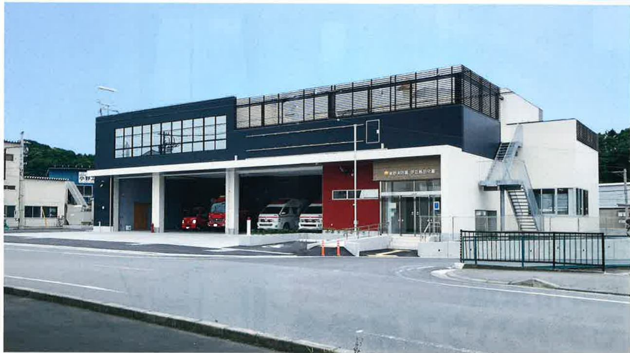
富士山南東消防署裾野消防署 伊豆島田分署／裾野市
