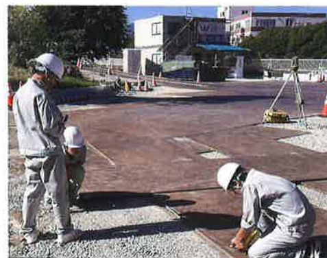
2日目 測量機器を使用し、位置出し体験
