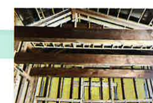
⑭2025.06.14 遮音性能検査 施工段階の遮音性能を確認し、 目標値をクリア！ INBOXの工事へ移行します
