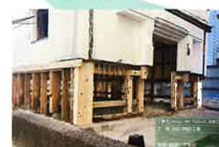
⑤2025.02 揚げ屋工事 腰壁部を撤去し揚屋の準備完了 構造体も揚げ屋に 耐えられるよう補強しました
