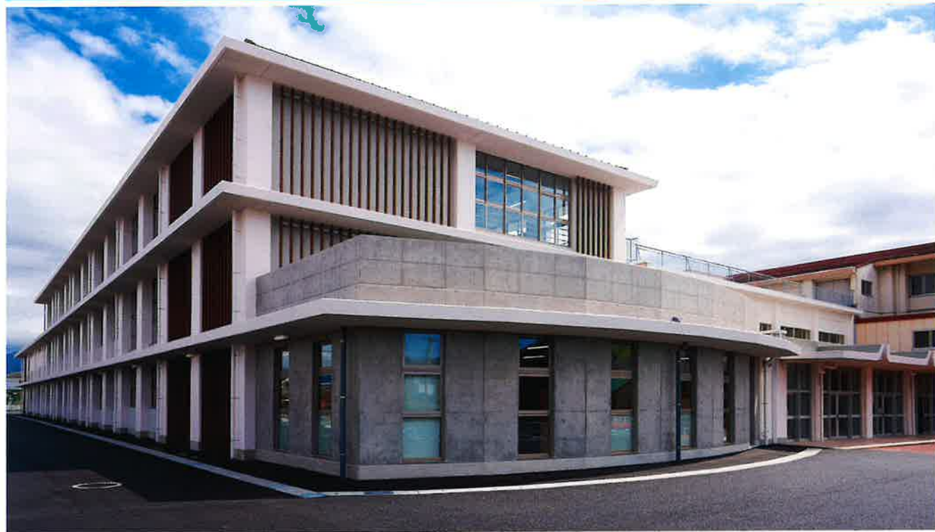
清水南小学校北校舎改築工事 (JV) / 清水町
