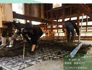
⑧2025.03 基礎工事 蔵を支える架台があるので 低姿勢での作業は大変でした。 しかも重機は使えないので すべて人力です
