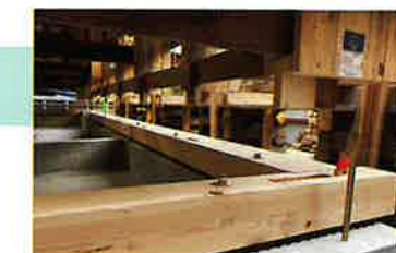
⑪2025.05 補強工事 構造強度及び防音性能を 向上させる為の工事です
