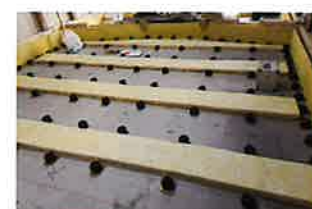
⑩2025.04下旬 浮床工事 INBOX構造の基礎と OUTBOX(蔵)基礎とが 接触しないよう防振ゴムを設置
