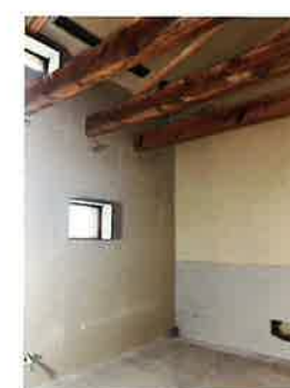
⑬2025.06 防音界壁工事 メインスタジオとブース及び エントランスとの間に 音が伝わらないようにする工事です
