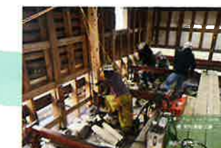
⑥2025.02中旬 揚げ屋工事 ジャッキアップ作業状況 慎重に！慎重に！作業しました
