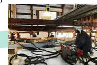
⑨2025.04 木工事 柱脚を加工し、新規の土台と緊結します
