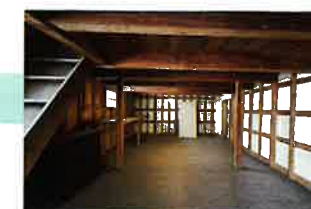
③2024.12着工前状況(1階) 改修前は2階建てでした
